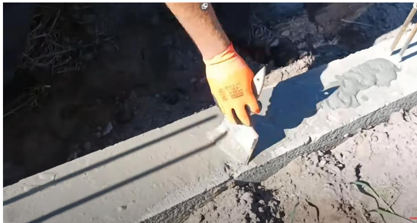
Zdj. 8 Pokrycie ławy fundamentowej płynną izolacją przeciwwilgociową.
